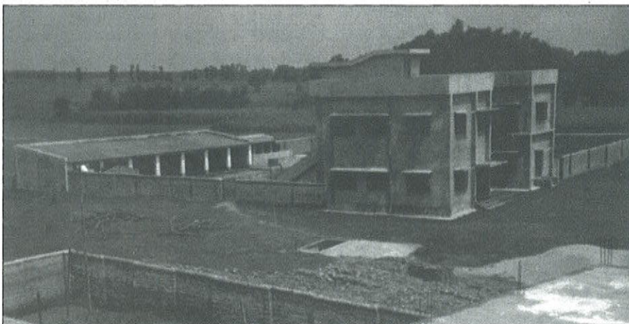
La casa del parroco e, in primo piano, il tetto della casa delle suore dove sarà costruito l'internato delle bambine (metà dei mattoni sono già stati completati)
